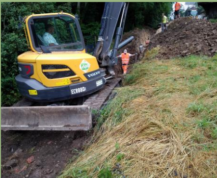
Travaux route d'Haroué
