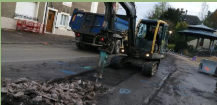
Travaux sur la route principale
