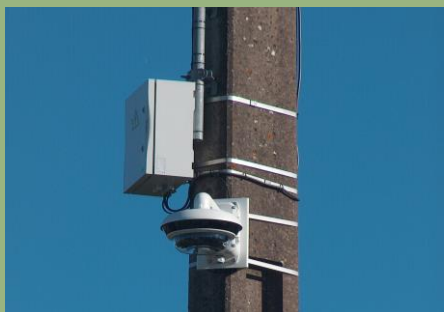
Installation d'une caméra
