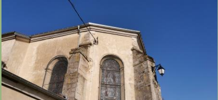
Réfection des chéneaux de l'église
