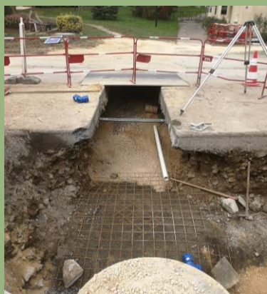
Installation de la pompe de relevage près de l'église
