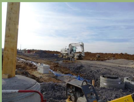
Début des travaux pour le lotissement
